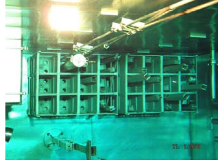
Figura 3. Piletta auxiliar para el almacenamiento de EECC irradiados.
