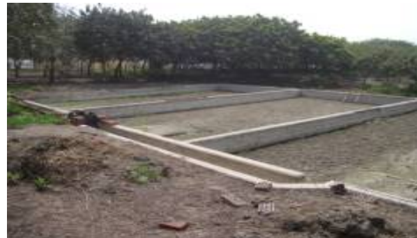
Figura 3. Lodos en la Piscinas de Lecho Filtrado.
