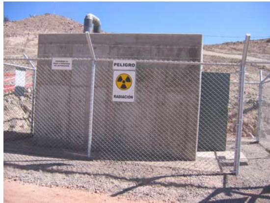
Figura 3. Vista lateral de almacén de fuentes radiactivas.
