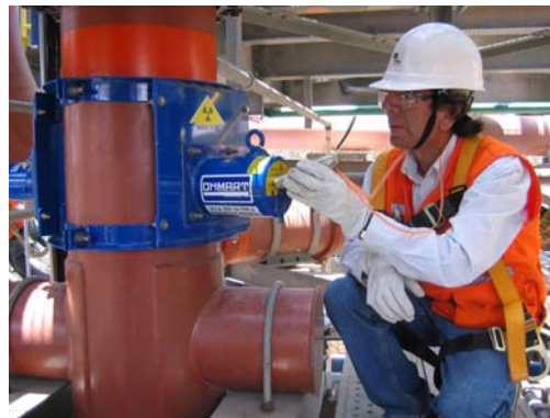
Figura 2. Verificación de tasa de dosis en contacto.
